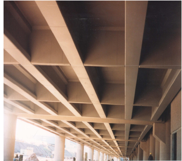
高架桥施工后
