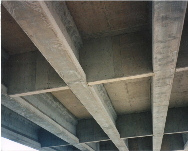
高架桥施工前
